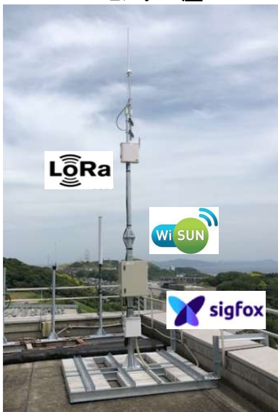
YRPセンター屋上
