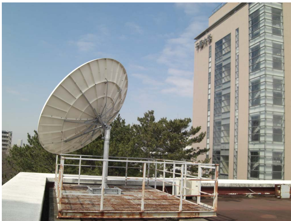
中国静止気象衛星FY2 データを受信するためのアンテナ
